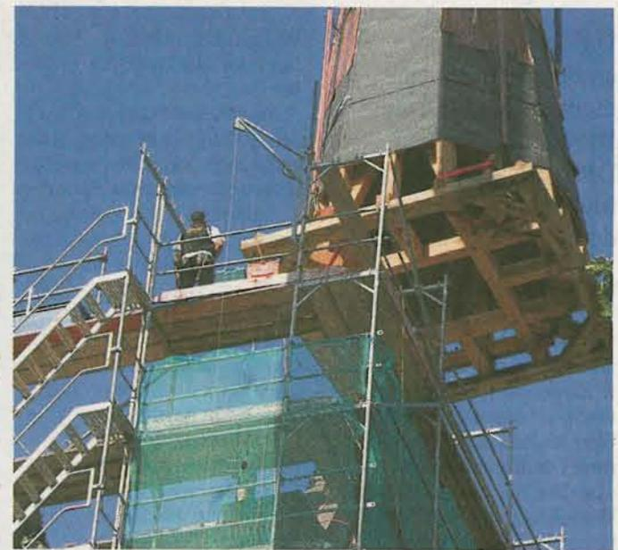
Die Turmspitze schwebt heran – sie muss exakt zwischen zwei Giebeln (vom Gerüst verdeckt) abgesenkt werden.
